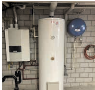
Alte Gasheizung und Boiler
