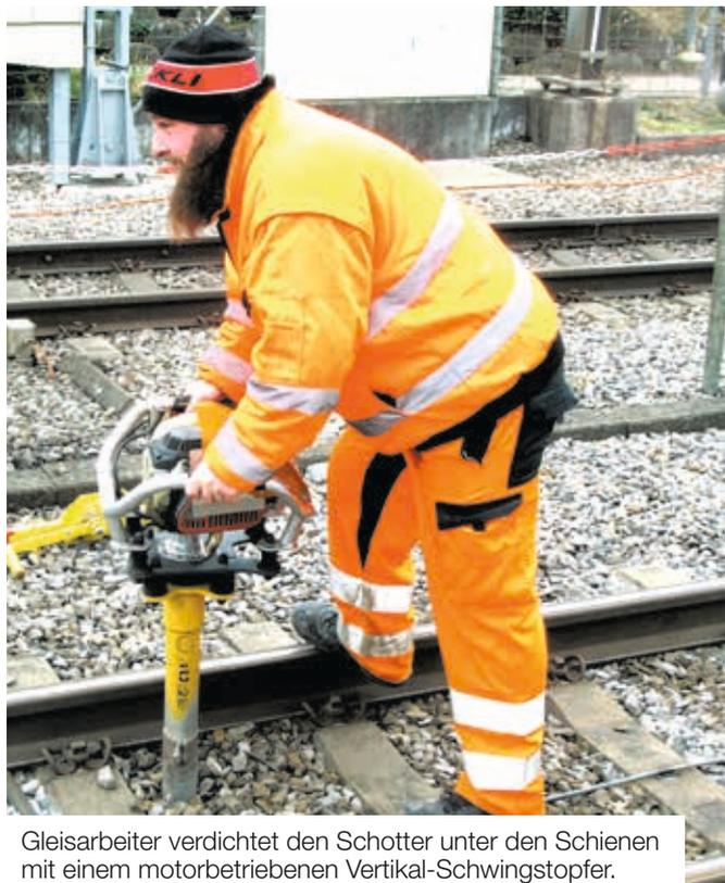
Gleisarbeiter verdichtet den Schotter unter den Schienen mit einem motorbetriebenen Vertikal-Schwingstopfer.
