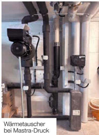
Wärmetauscher bei Mastra-Druck
