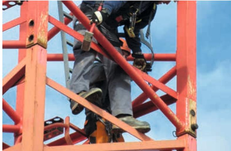
Rechts steckt noch der untere Sicherungsbolzen bis zum Anhängen des Turmelements am Pneukran, links sind beide entfernt.
