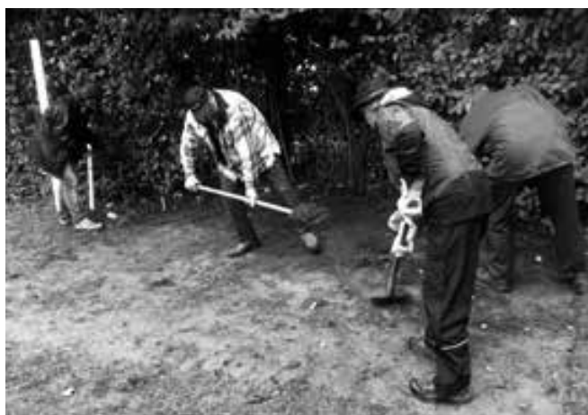
Vorbereitung für das Gartenhaus, 2021
