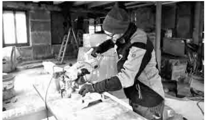
*Arbeiten mit der Handkreissäge*
