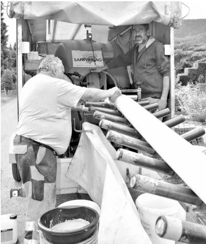
Martin bestreicht mit synthetischem Öl (trinkwassertauglich) den Liner, damit er gleitfähig wird
