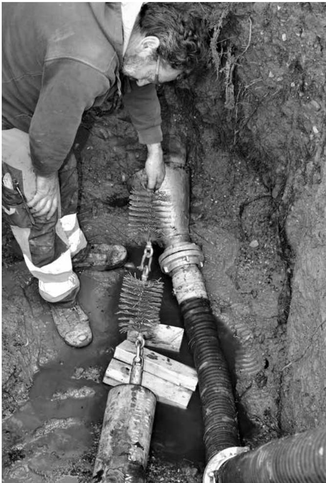
*Vor der Reparatur, wird noch einmal eine Stahlbürste durch das Rohr gezogen, anschliessend mit dem «Molch» getrocknet*
