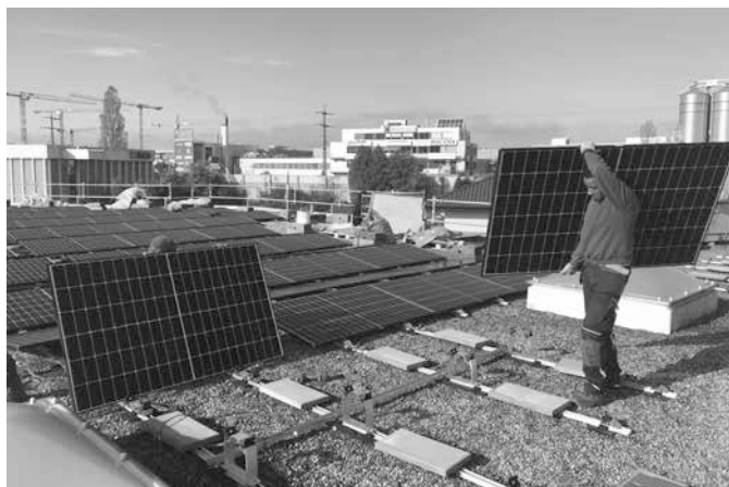
Die Solarpanels werden montiert
