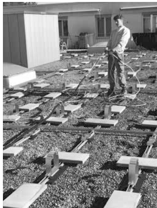
Installation der Verkabelung
