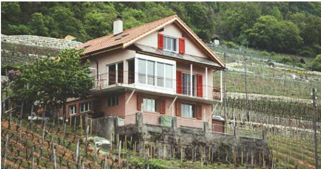
Solaranlage an Fassade
