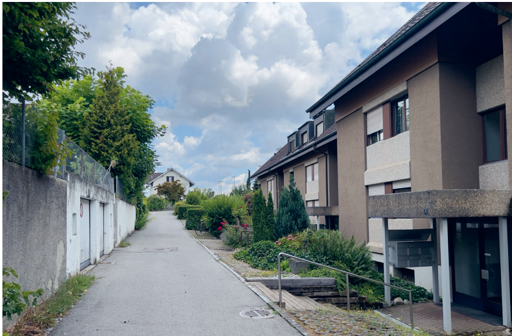
Abb. 4 Aktuelle Situation auf der Nordseite des Mehrfamilienhauses (eigene Aufnahme, Juli 2025)
