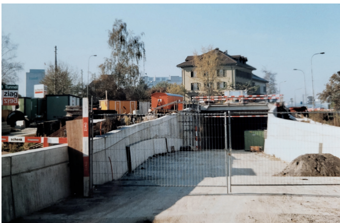
Bau des Tunnels ESS 1998
