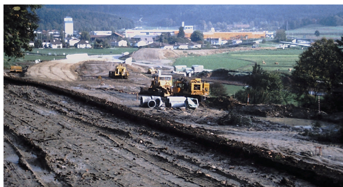
Bau der Autobahn A6 im Bubenloo 1986
