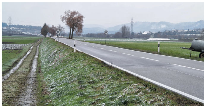
Die bis zu 2 m hohe Dammkonstruktion ödlich von Schönbühl
