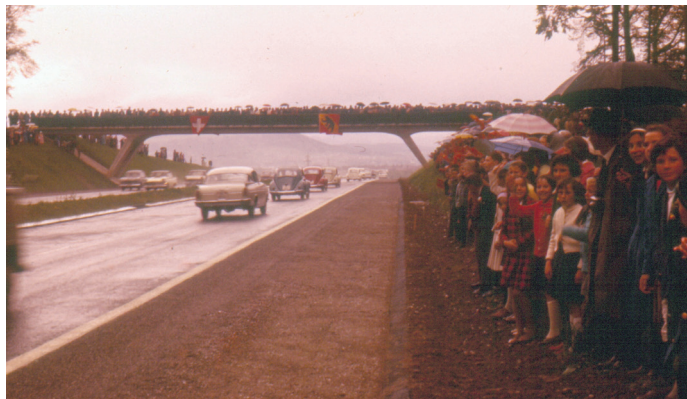
Eröffnung der Autobahn im Grauholz 1962
