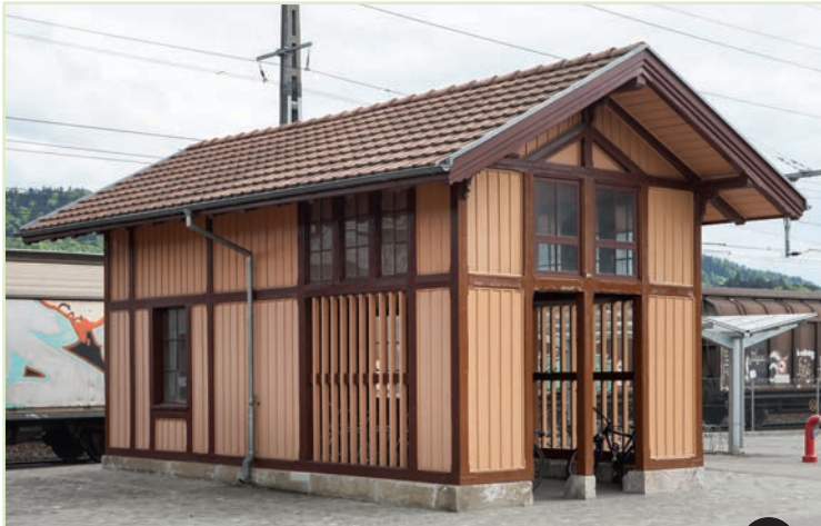
24 Nebengebäude, Bahnhofstrasse 16c Ehemalige Toilettenanlage und Remise der Bahnstation, erbaut 1873. Schlichter Ständerbau unter Satteldach.
