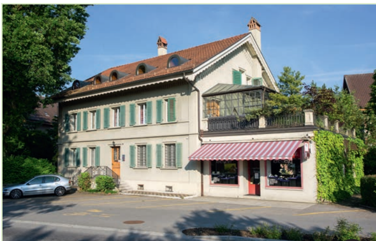
28 Doktorhaus, Solothurnstrasse 13 Das sogenannte Doktorhaus mit einer spätklassizistischen Haussteinfassade und zentralem Eingangsbereich wurde 1858 erbaut, traufständiges Satteldach und Anbau unter der Terrasse.
