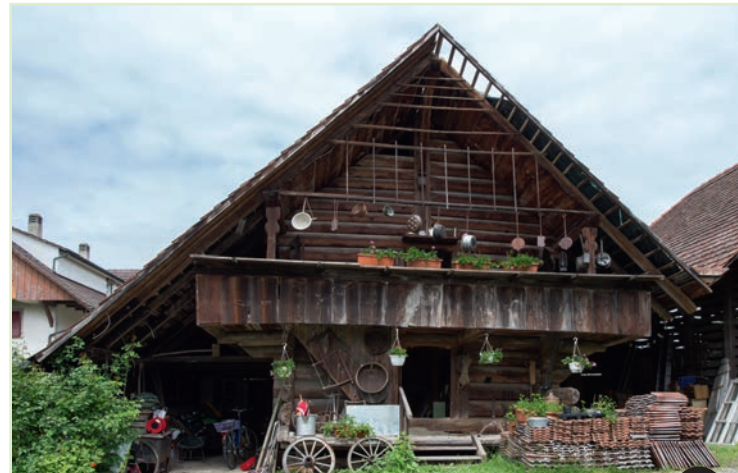
➤ Speicher, Unterdorfstrasse 9a Speicher von 1688; kraftvoller Hälbling-Blockbau unter steilem Satteldach, umlaufende Laube im Obergeschoss auf mächtigen Blockkonsolen. Der Speicher ist einer der ältesten Bauten in Urtenen.
