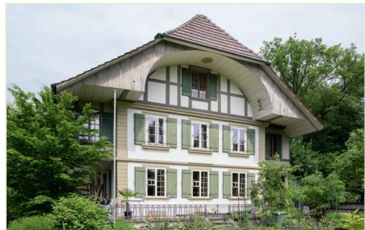
➤ Wohnstock, Unterdorfstrasse 9 Wohnstock, erbaut 1830. Nobler Biedermeier Massivbau, klare Sandsteingliederung, Ründldach, eingewandte, mit feinen Holzschindeln verrandete Traufлаuben auf toskanischen Sandsteinsäulen. Eine Besonderheit sind die unterschiedlichen Fenster: Im Erdgeschoss noch kleine und im Obergeschoss grossere Scheiben.
