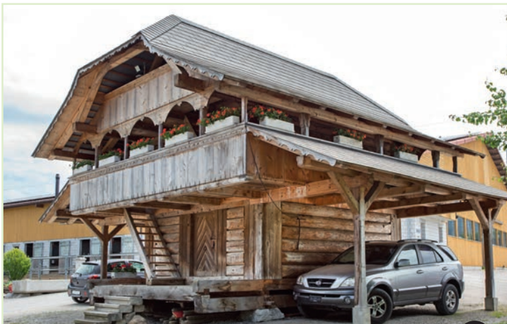
➤ Speicher, Solothurnstrasse 10a Ein Speicher aus dem Jahre 1742; ausdrucksstarker Hälbling-Blockbau unter Viertelwalmdach; im Obergeschoss mit umlaufender Laube.
