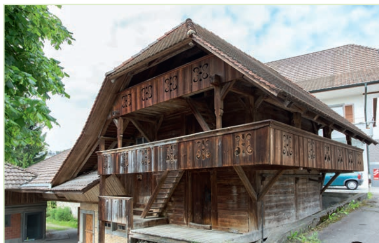
➤ Speicher, Unterdorfstrasse 2a Speicher, qualitativoller Kantholz-Ständerbau auf doppeltem Schwellenkranz, Lauben im Ober- und Dachgeschoss mit dekorativen Ausschnitten; erbaut 1755
