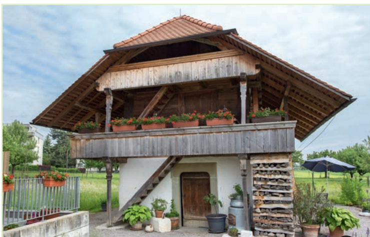
29 Ofenhaus und Speicher, Unterdorfstrasse 1b Ofenhaus und Speicher, erbaut 1755; Ständerbau auf Bruchsteinmauerwerk im Erdgeschoss, Viertelwalmdach und umlaufender Laube im Obergeschoss. Der zierliche Kleinbau ist sorgfältig durchgestaltet; schlichte Brettertür im Erdgeschoss mit Schulterbogen-Sandsteinsturz.
