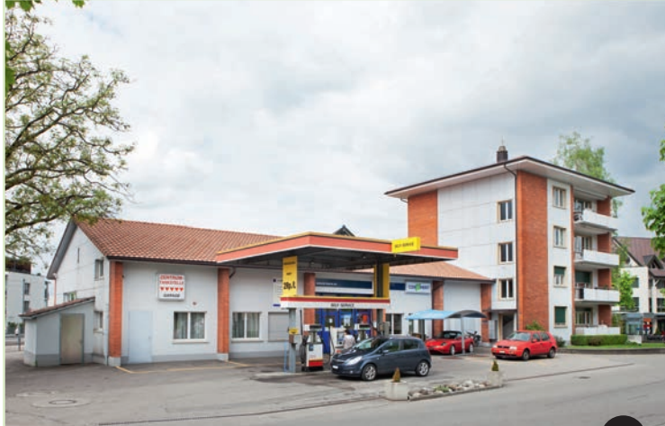
➤ Wohnhaus mit Gewerbeanbau, alte Bernstr. 12 Das Wohnhaus mit Gewerbeanbau wurden 1956 erbaut; der sorgfältig gegliederte zweiteilige Baukörper zeigt charakteristische Elemente der 1950er Jahre: Gliederung der Fassade durch Balkone mit gelochten Eternitbrüstungsplatten, Putz- und Sichtbacksteinflächen sowie herausragendes schwach geneigtes Pyramidendach.
