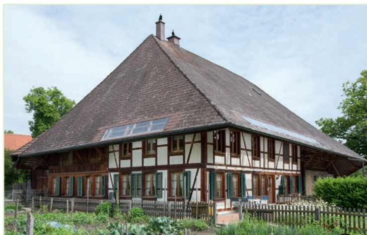
➤ Bauernhaus, Mühlestrasse 2 Doppel-Bauernhaus, erbaut in zwei Phasen, 1800 bzw. 1850. Mächtiger Baukörper unter imposantem heruntergezogenem Vollwalmdach. Auffallend ist die unterschiedliche Bauweise der beiden Haushälften: der ältere Teil ist in Ständerbauweise erstellt, der jüngere in Sichtriegelwerk.
