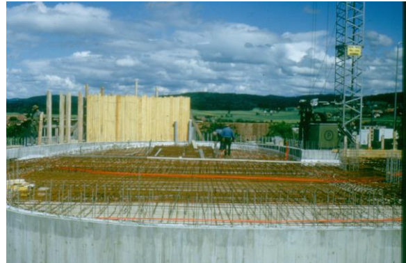
Aus der Bauphase
