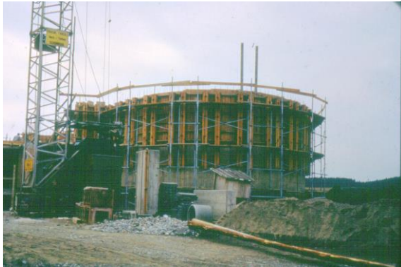
aus der Bauphase
