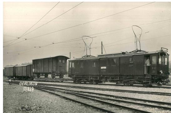
Gütertriebwagen Fe 4/4 21 mit einem SBB-Güterwagen auf einem Rollschemeel sowie zwei schmalspurigen Güterwagen im Eröffnungsjahr 1916 in Solothurn.
