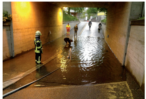
Hochwasser in der Unterführung Moosstrasse
