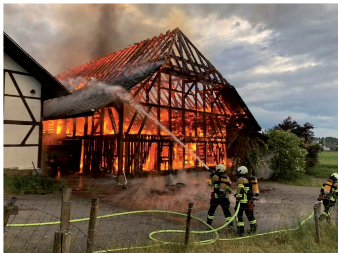
Brand des Bauernhauses an der Sandstrasse
