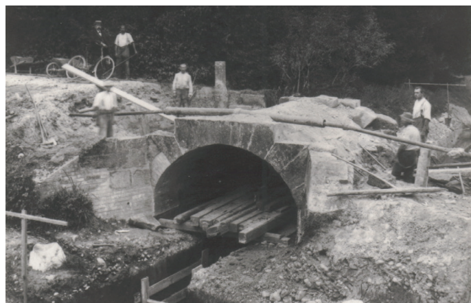
Kanalbau anlässlich der dritten Tieferlegung der Urtenen 1917
