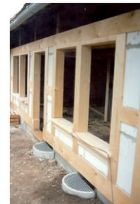
Die Ostfassade im ursprünglichen Zustand und die neue Grundkonstruktion mit Fundamenten (Fotos Toni Candinas)
