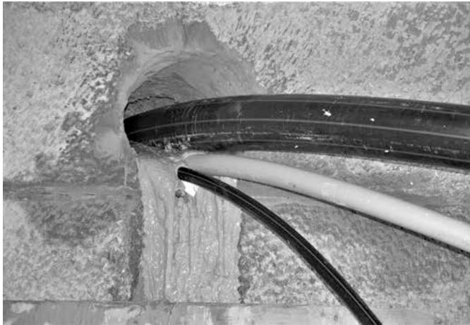
Bentonit läuft zum Bohrloch hinaus
