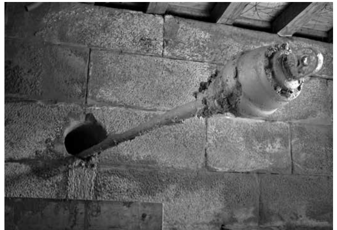
Der grosse Durchmesser ist geschafft, der Bohrkopf hat den Endpunkt erreicht
