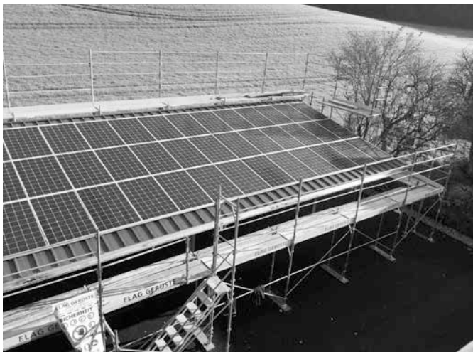
PV-Anlage im Bau
