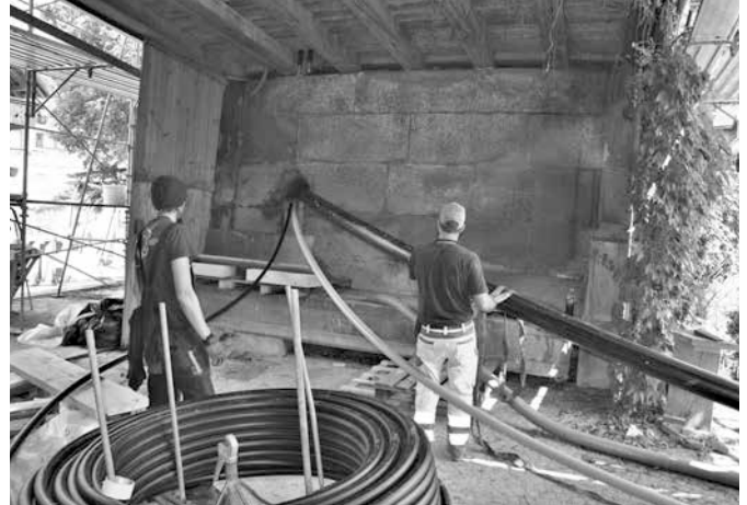
Sorgfältig werden die Rohre eingeführt
