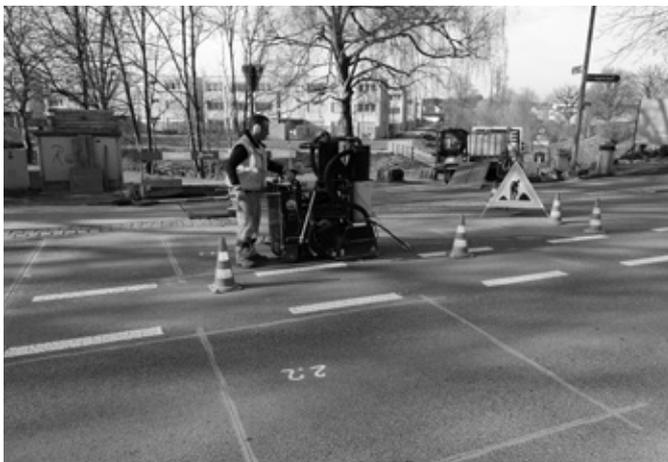
Schritt 1: In den Strassenbelag werden Schlitze gefräst
