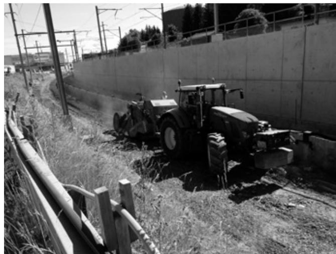
Abtrag der Foundationsschicht auf dem alten Trasse
