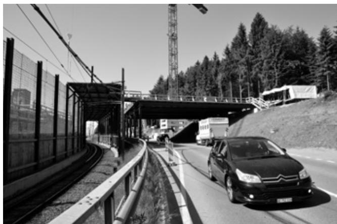
Die Schutztunnels über Schiene und Strasse ermöglichen gefahrlose Kranarbeit
