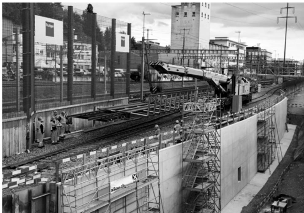
Einbau der ersten Hilfsbrücke mit dem SBB-Kirow-Kran
