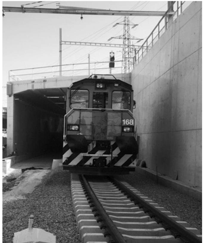
Mit dem RBS-Bauzug wird das neue Bahngleis verlegt, Hauptschotterung und Fahrleitung folgen
