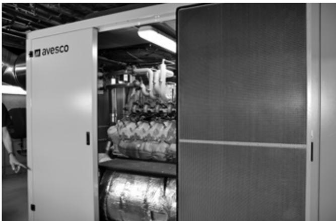
Aus Biogas entsteht hier Elektrizität – normalerweise hinter dem Schallschutz
