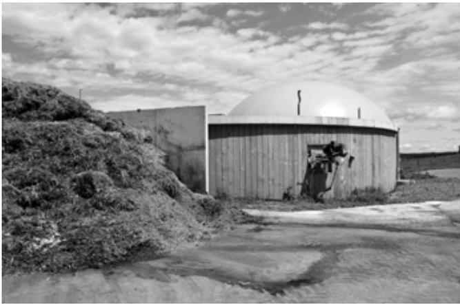
Aus dem Mist links macht der Bioreaktor im Hintergrund Energie
