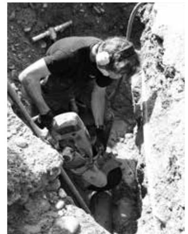
Mit dem «Trennjäger» wird das defekte Rohrstück herausgeschnitten
